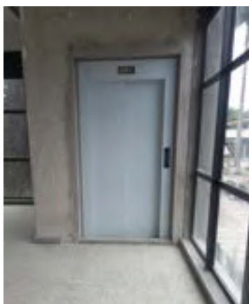
Figura 54 - Edifício Fábio Ribeiro Gomes: instalação de elevador.
