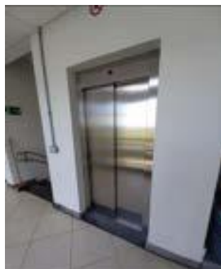
Figura 56 - CIP CRP: instalação de elevador.
