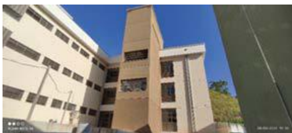
Figura 38 - Fachada frontal do Observatório.
