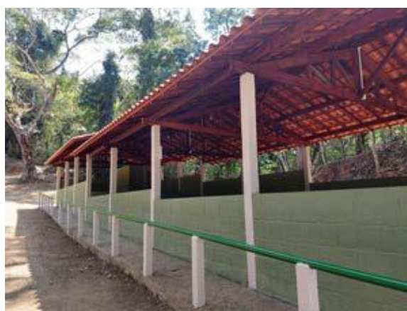
Figura 44 - Pintura e troca do telhado das estruturas adjacentes.
