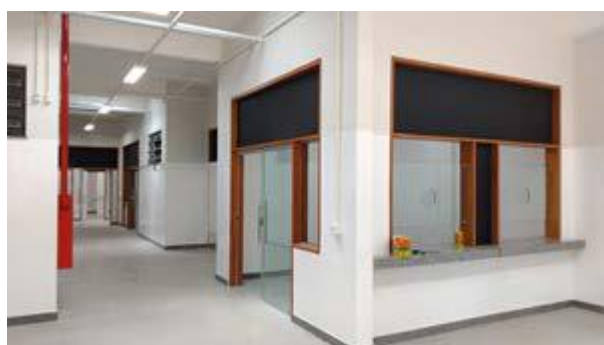
Figura 27 - Reforma e ampliação do Hospital Veterinário.
