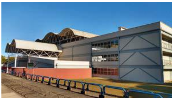
Figura 25 - Reforma da fachada do PVB.
