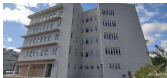
Figura 37 - Fachada lateral do Edifício Idata.
