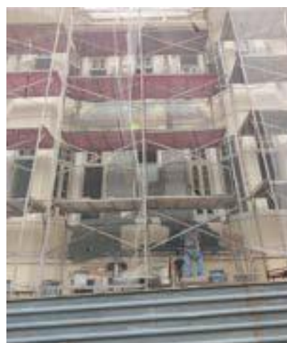
Figura 34 - Fachada lateral do edifício Unidade de Moradia Estudantil - Velho (obra em andamento).
