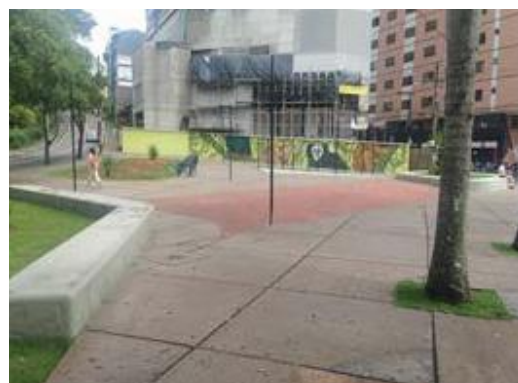
Figura 43 - Execução do piso em PVA-S, bancos e instalações elétricas.
