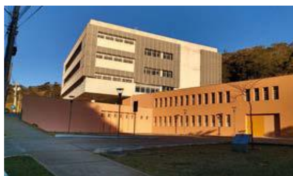
Figura 28 - Execução de textura na fachada do DEM.
