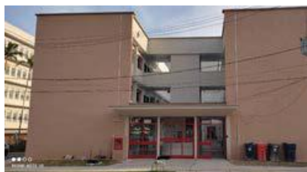
Figura 30 - Fachada da Unidade de Moradia Estudantil – Novíssimo.
